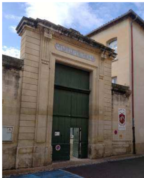
The entrance portal to the Hôtel de Murs
